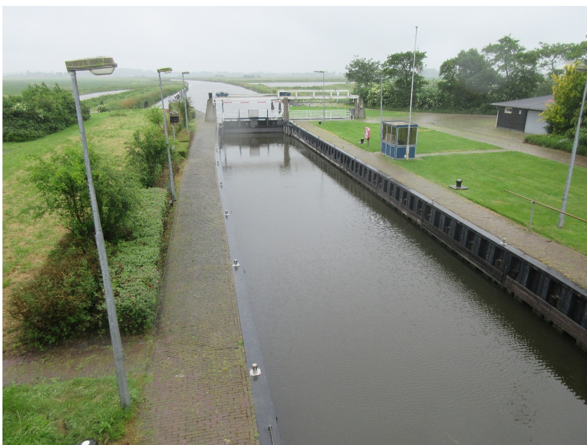
Gemaal De Waakzaamheid heeft een vispassage.
