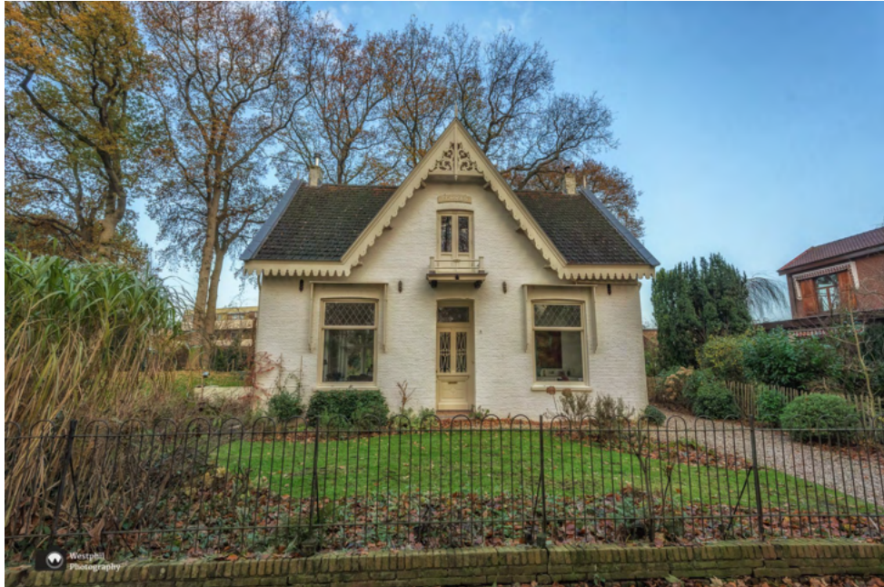
- Villa het 'Terras'; één van de vrijstaande huizen.-
