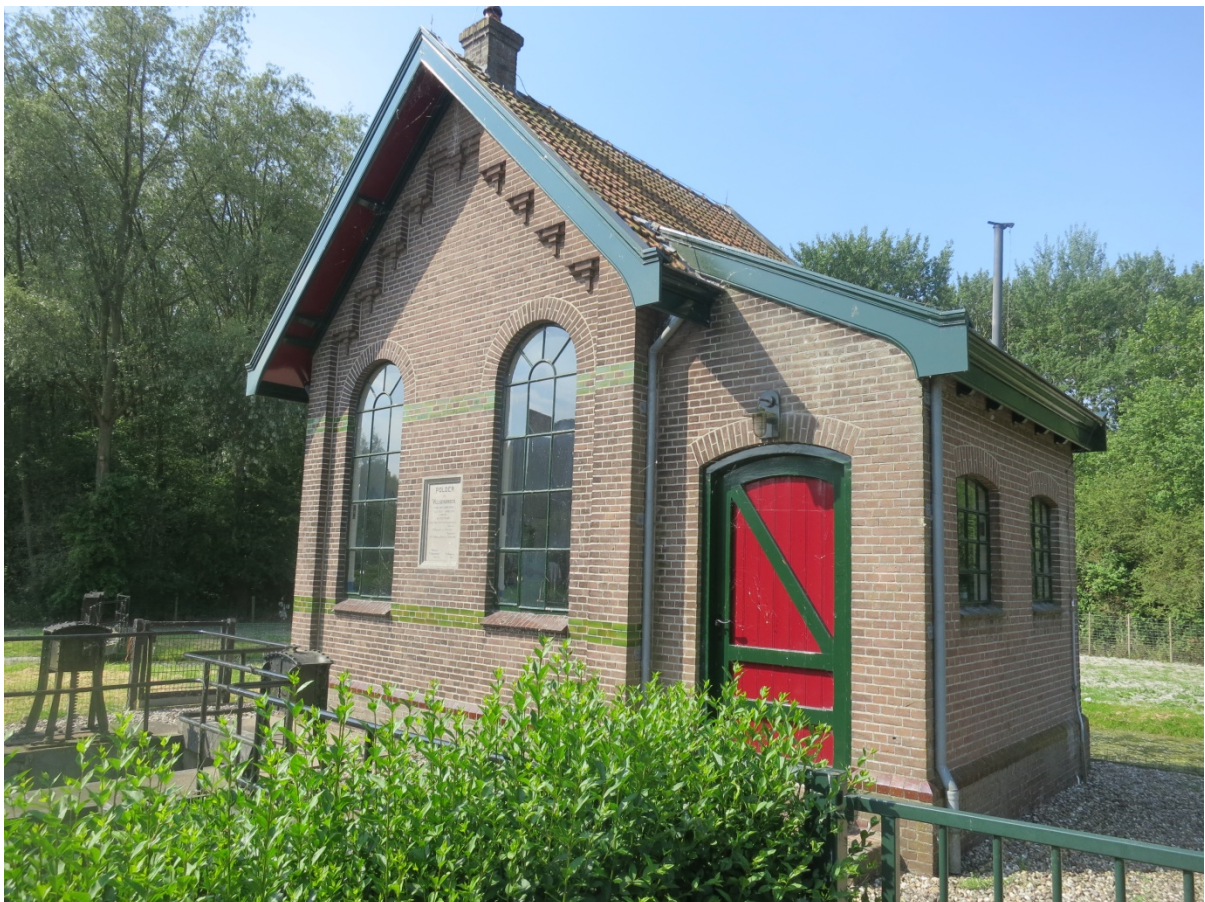
Gemaal De Velsbroek is onderdeel van de Stelling van Amsterdam.
